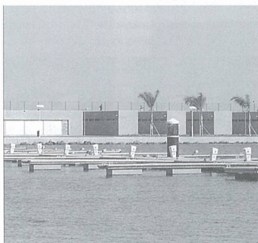
Aseos y paños en el puerto deportivo de Mazagón, Huelva. Luisa Alarcón y M o Luz Galdames.
