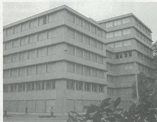
Edificio de oficinas, de Diener&Diener
