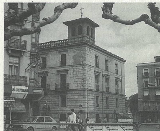
Casa de los Chapiteles 1983. Enciclop. de la Rioja
