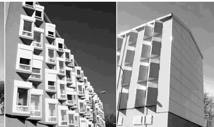
Bloque rehabilitado. Fachada oeste.
