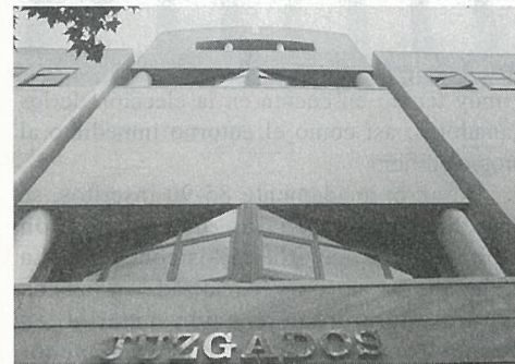
ampliación de los Juzgados de Logroño
